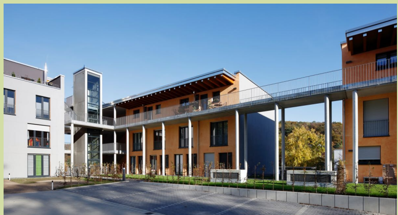
Blick von Steinbruch auf 1. Bauabschnitt
