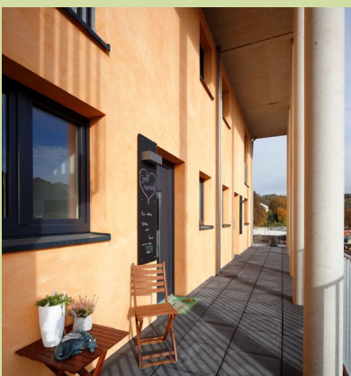
Blick auf Galerie 1. Bauabschnitt
