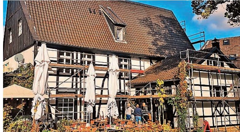
Denkmalpflege Stiftsplatz 5 (Fassadensanierung)
