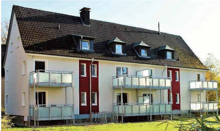
Neue Balkone Oststraße 9-11
